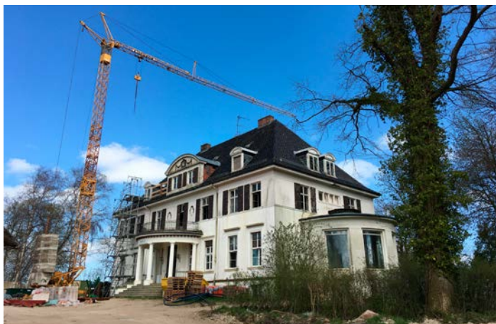
Das Gebäude Gut Rothensande ist bekannt aus dem Fernsehen als „Gut Immenhof“. Das Gebäude erhielt eine nachträgliche Horizontalsperre mit Edelstahlplatten.
