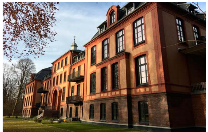
Umbau eines ehemaligen Kinderheimes in hochwertige Wohnungen. Hier wurden nachträglich Horizontalsperren mit Edelstahlplatten eingebaut.
