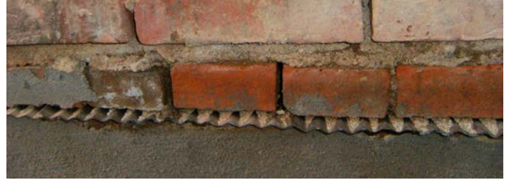
Mechanische Horizontalsperre
