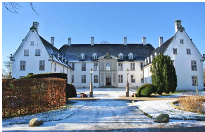
Vor zwei Jahren haben am Schloss Schackenborg (ehem. Sommersitz der dänischen Königsfamilie) Hallwas und sein Team Voruntersuchungen vorgenommen, die für geplante Sanierungsarbeiten notwendig sind.
