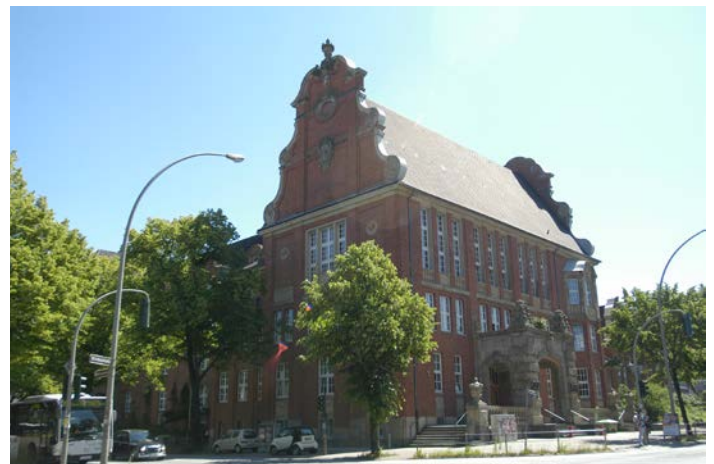
An der staatlichen Gewerbeschule für Installationstechnik in Hamburg wurden Bereiche des Kellers saniert. Die Firma „Sanierungstechnik-Nord GmbH“ führte hier Mehrstufeninjektions- und Sanierputzarbeiten aus. Mehr Infos finden Sie unter www.Salpeter.de .
