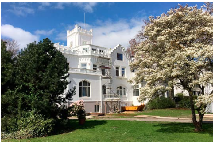
An diesem Objekt wurde der Keller vollständig neu abgedichtet. Eingesetzte Verfahren waren Horizontalsperre mit Edelstahlplatten und Schleierinjektionsarbeiten. Die Kellerwände wurden unterfangen und ein neuer Fußbodenaufbau nach neuestem Stand der Technik eingebaut. Alle Wände erhielten im Keller einen Sanierputz. Kostenumfang ca. 630.000,00€.
