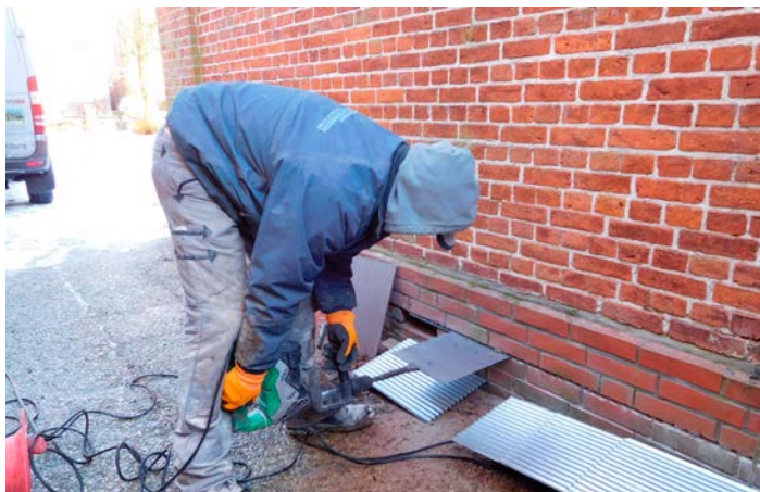
Einbau der mechanischen Horizontalsperre mit Chromstahlblech
