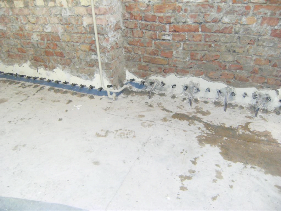
Foto 6: Erst nach dem Injektionsverfahren wurde der Altputz entfernt
