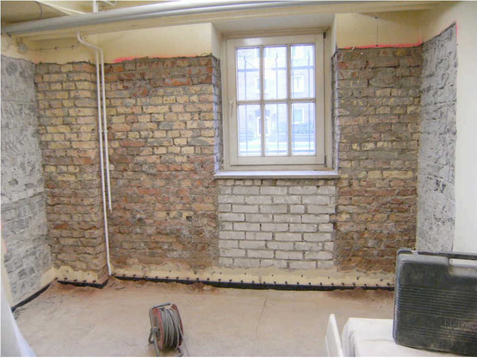
Foto 7: Die Putzarbeiten können beginnen
