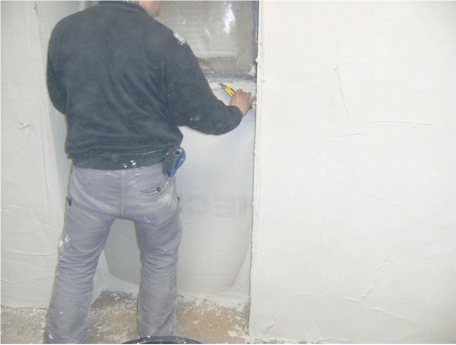
Foto 8: Anbringen eines Armierungsgewebes in die zweite Sanierputzschicht, um Rissbildungen vorzubeugen
