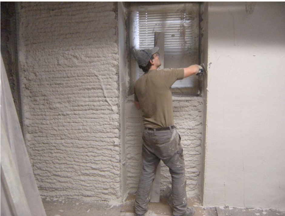
Foto 9: Auf der rechten Wandseite ist das Sanierputzsystem bereits fertig gestellt
