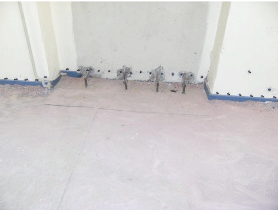
Foto 4: Die Vorbereitungen sind abgeschlossen und das mehrstufige Injektionsverfahren hat begonnen.
