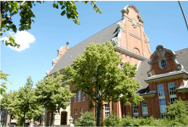
Fotos 1 und 2: Außenansichten der Staatlichen Gewerbeschule für Installationstechnik in Hamburg: Das altherwürdige Schulgebäude aus den Jahren 1908/1909 ist nach den Sanierungsarbeiten wieder voll nutzbar
